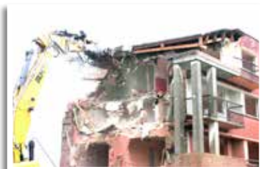
Démolition du bloc Alsace en octobre 2013
