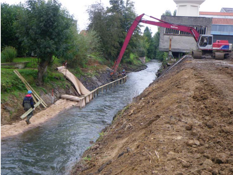
chantier Etilam (photo: SIAHSA, 2010)
