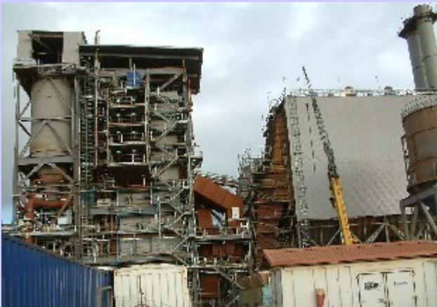
A gauche :chaudière tranche 2, à droite : électrofiltre
