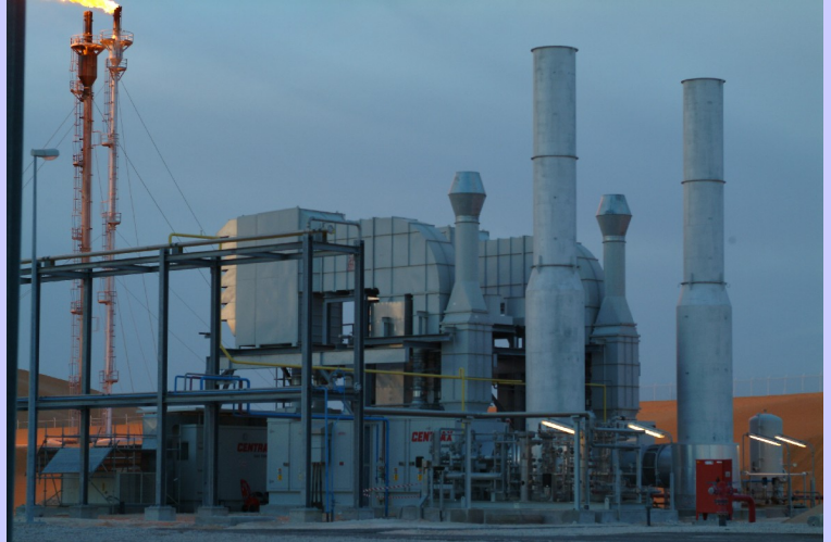
Algérie : Turbines à gaz pour le secours. 2 x 5MW, torches.
