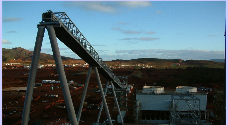
Convoyeur à charbon en cours de montage et tours de refroidissement d'eau pour le condenseur de la tranche 1.
