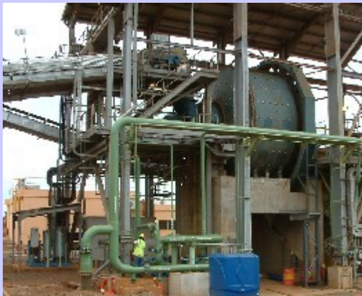
Broyeur, laverie de minerai, Tiébaghi (Nord).
