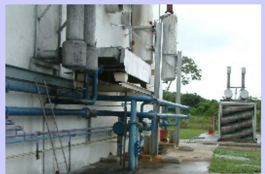
Ile de Lifou. Centrale électrique, groupe électrogène. Problème de régulation de température sur les groupes (mauvaise gestion des circuits de refroidissement).
