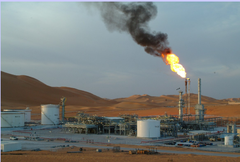
Algérie : une partie de l'installation.
