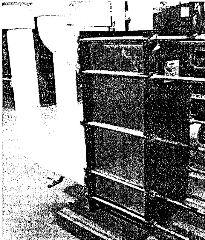
Photo de l'échangeur à plaques
